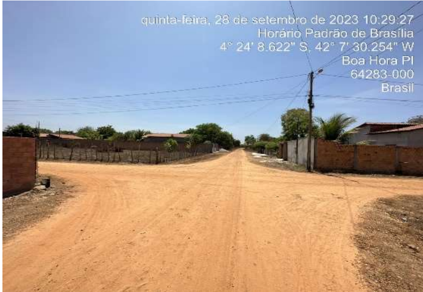
Imagem 03 - CABEÇA DE RUA (RUA PROJ. 10)
