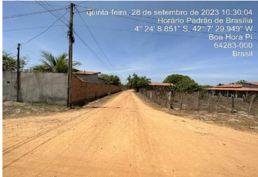
Imagem 05 - CABEÇA DE RUA (RUA PROJ.)
