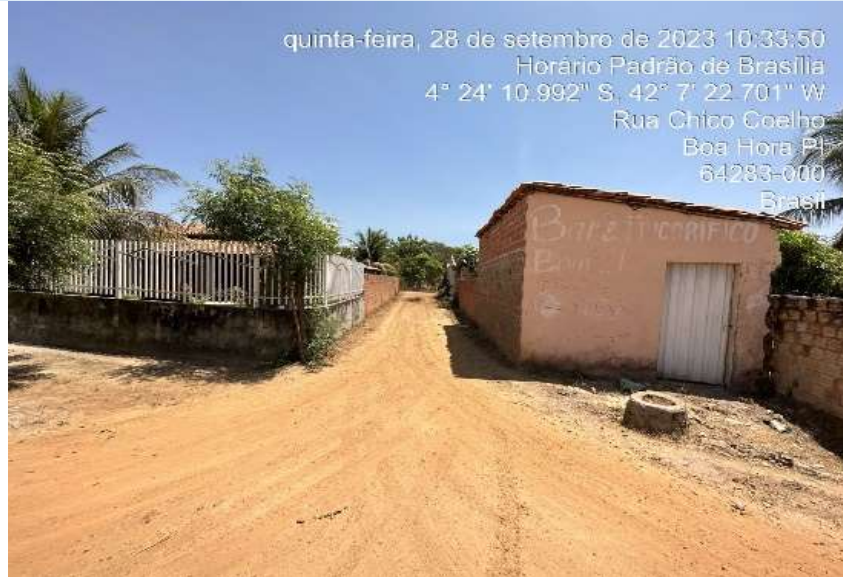
Imagem 06 - CABEÇA DE RUA ( RUA PROJ.)
