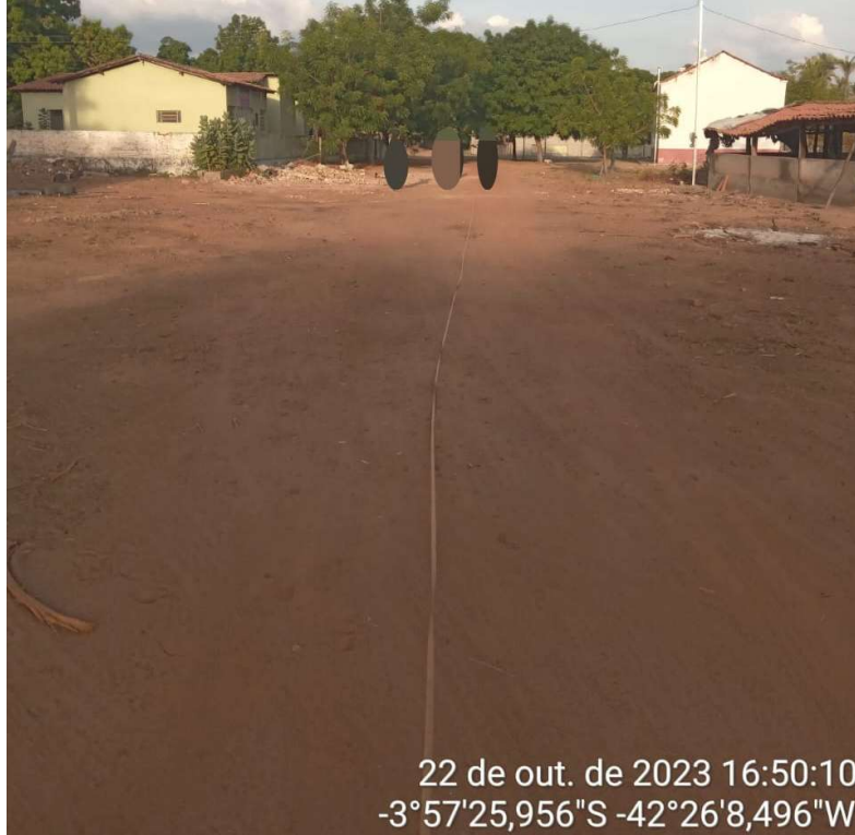
Imagem 03 - Início da rua Projetada 02
