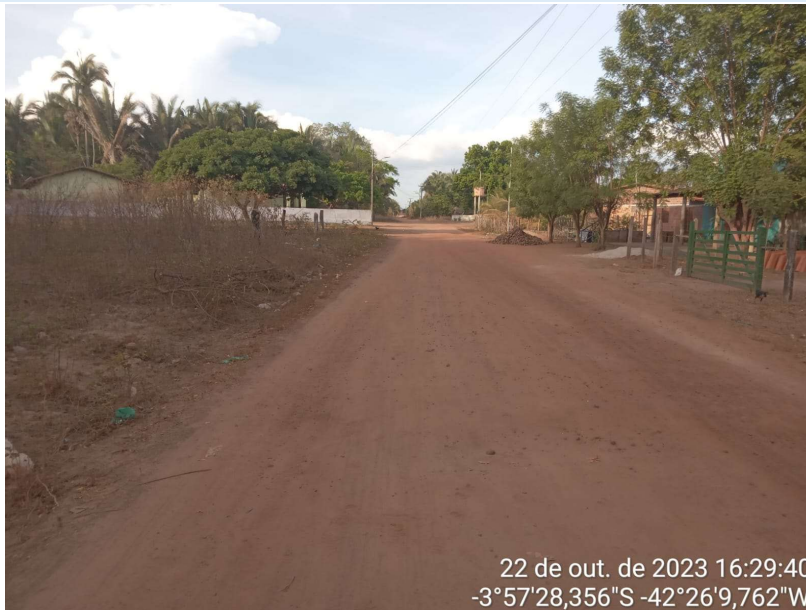
Imagem 01 - Início da rua Projetada 01
