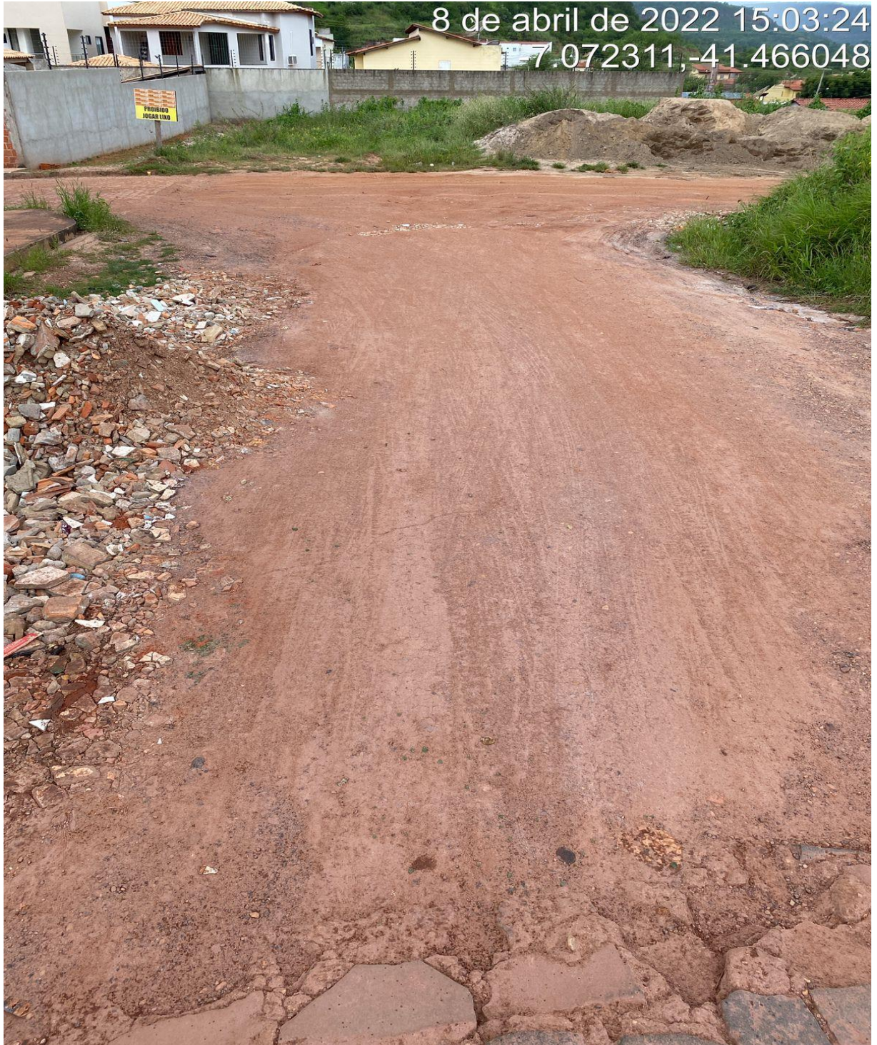
FOTO 04 - RUA 02 PROJETADA S/N - LOC. BOMBA
