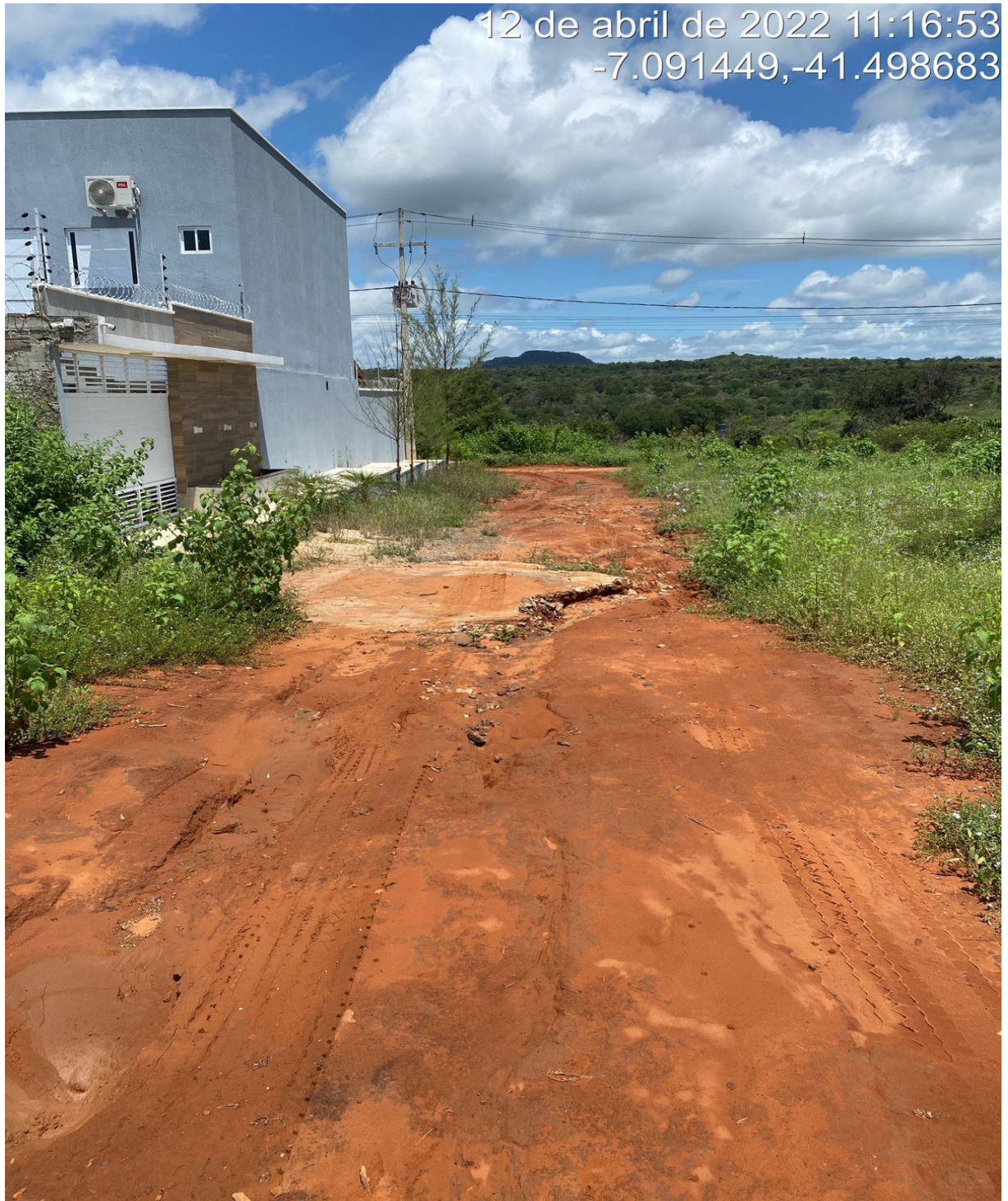
FOTO 16 - RUA 16 PROJETADA S/N - LOC. BELO NORTE
