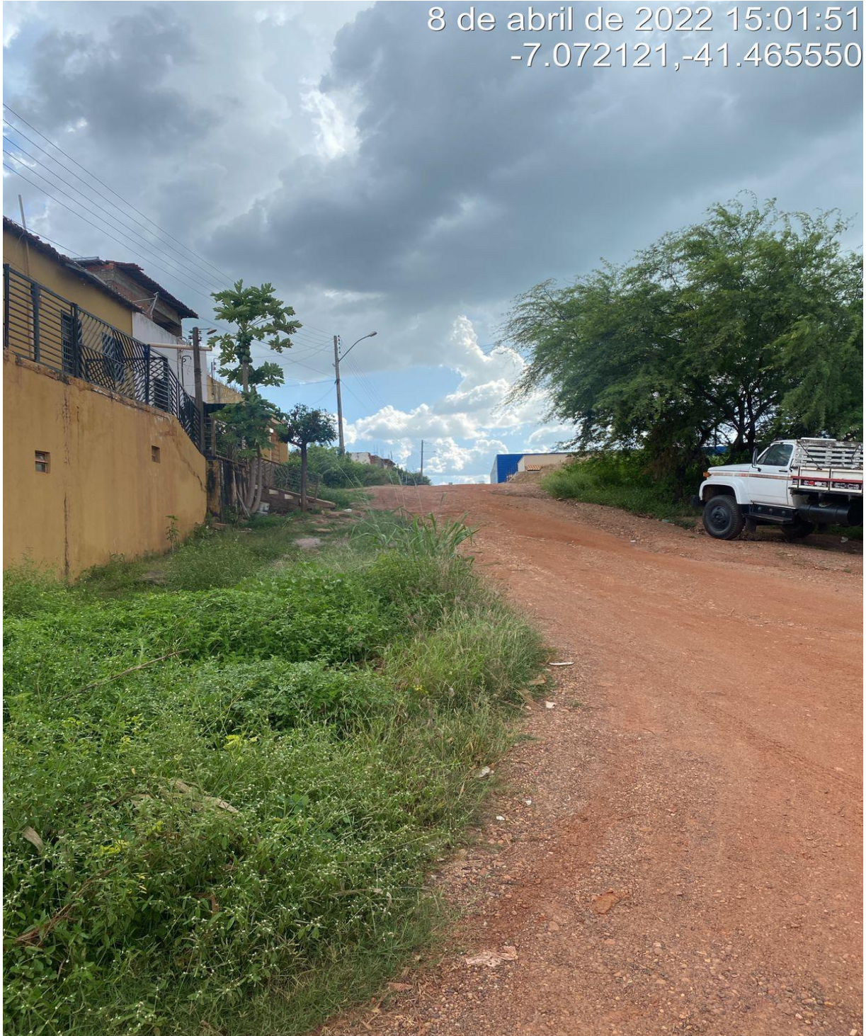
FOTO 02 - RUA 01 PROJETADA 335 - LOC. BOMBA
