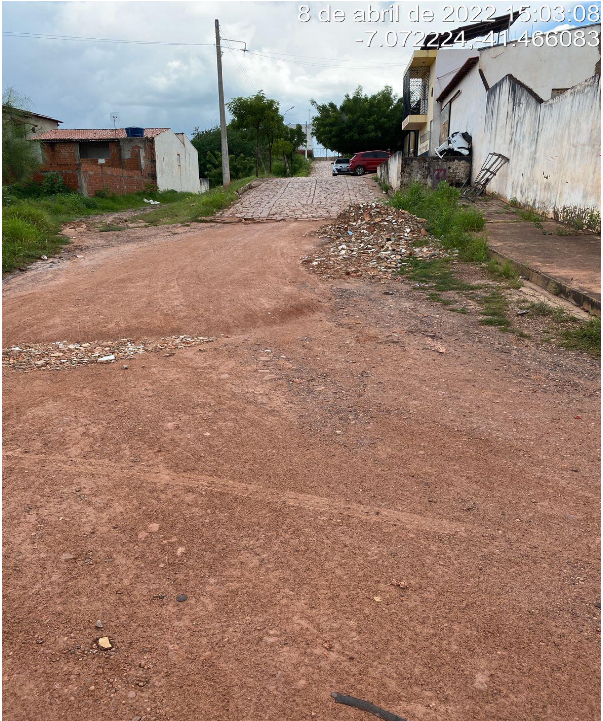
FOTO 03 - RUA 02 PROJETADA S/N - LOC. BOMBA
