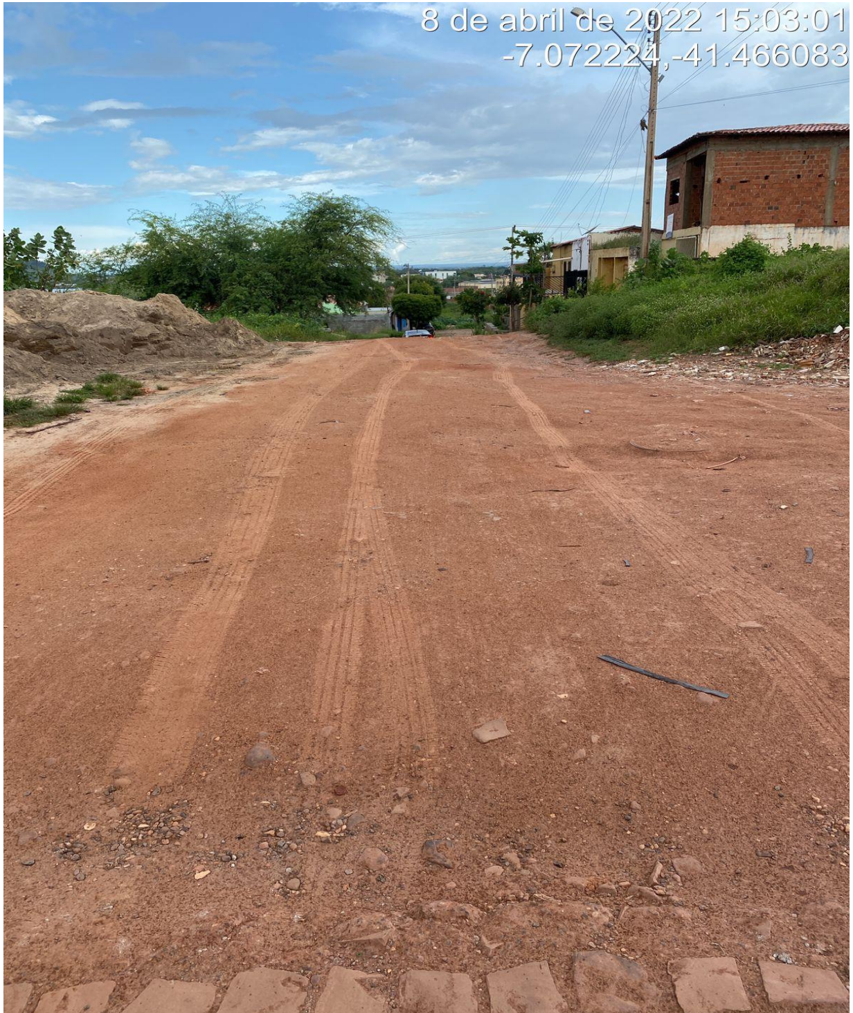
FOTO 01 - RUA 01 PROJETADA 335 - LOC. BOMBA
