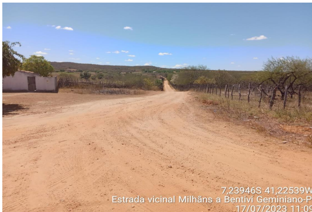
FOTO 12 - TRECHO 03 - MILHÃNS A BENTIVI
