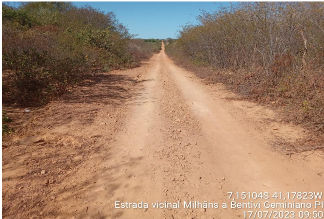
FOTO 07 - TRECHO 01 - MILHÃNS A BENTIVI
