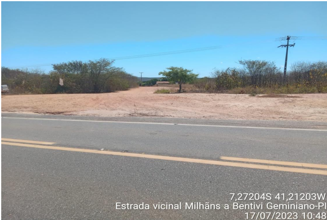
FOTO 01 - TRECHO 01 - MILHÃNS A BENTIVI
