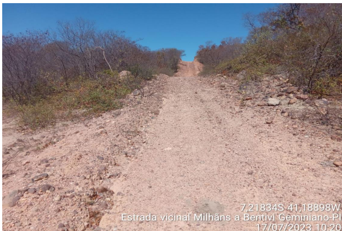
FOTO 04 - TRECHO 01 - MILHÃNS A BENTIVI
