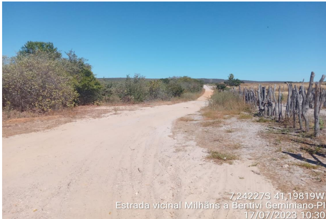
FOTO 03 - TRECHO 01 - MILHÃNS A BENTIVI
