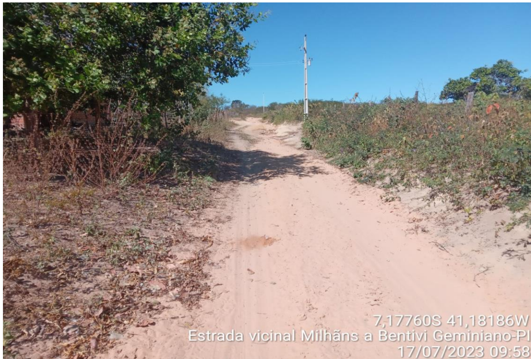
FOTO 06 - TRECHO 01 - MILHÃNS A BENTIVI
