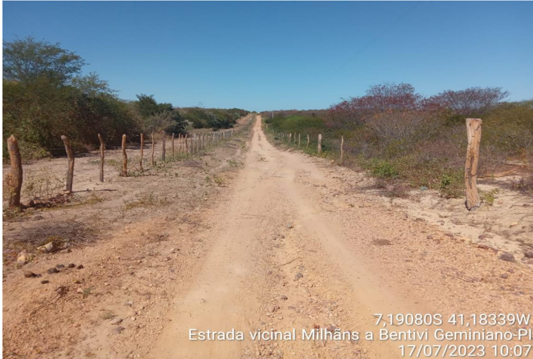
FOTO 05 - TRECHO 01 - MILHÃNS A BENTIVI
