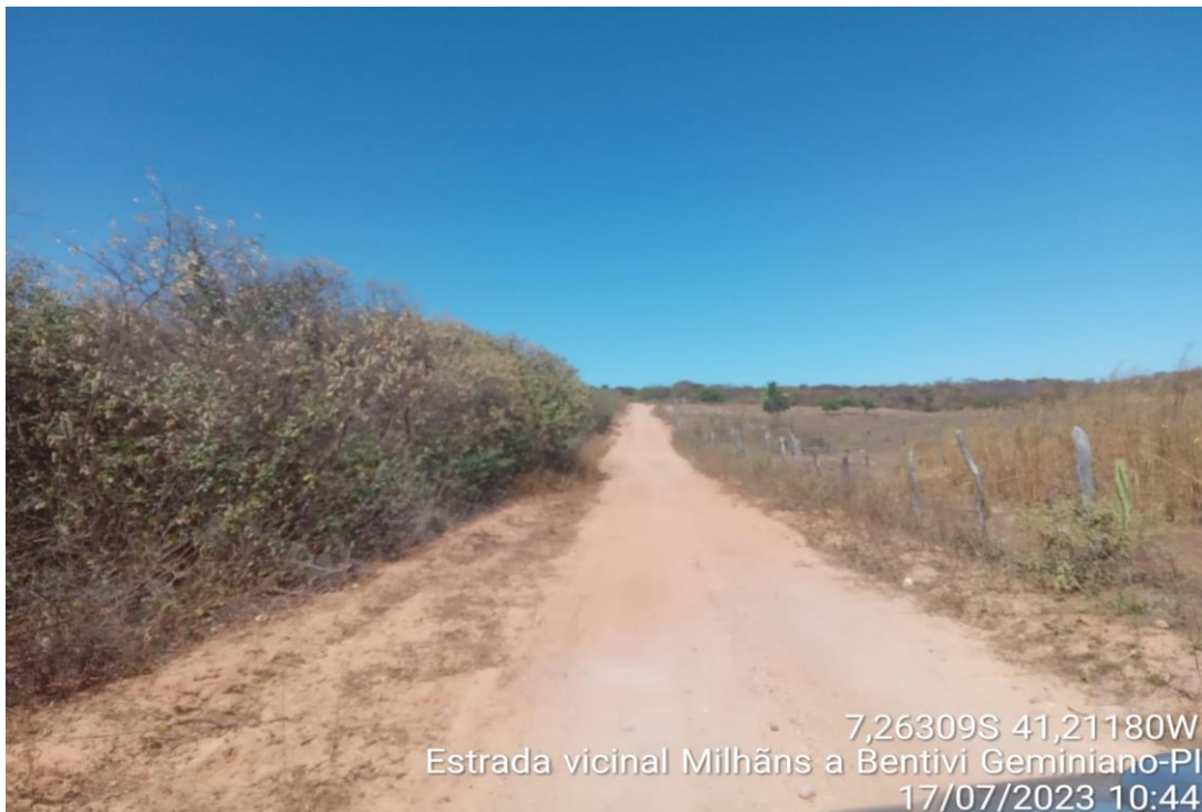
FOTO 02 - TRECHO 01 - MILHÃNS A BENTIVI
