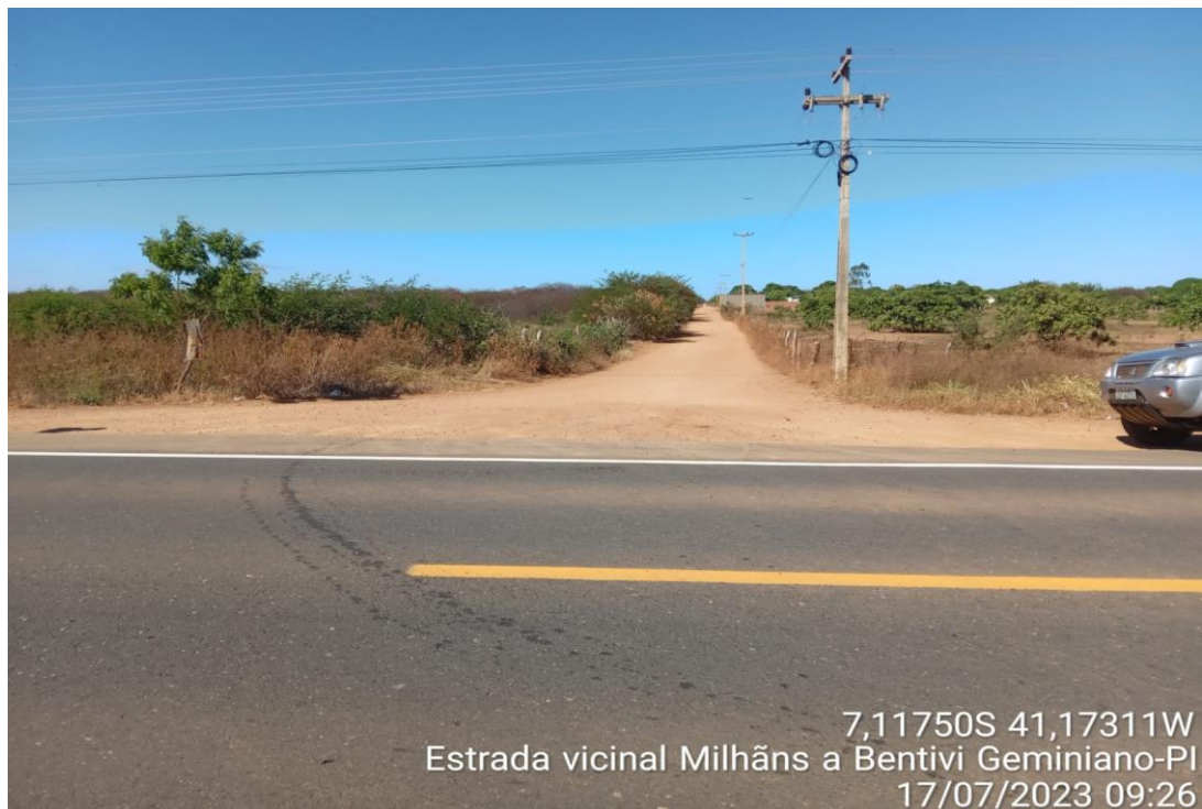
FOTO 08 - TRECHO 01 - MILHÃNS A BENTIVI
