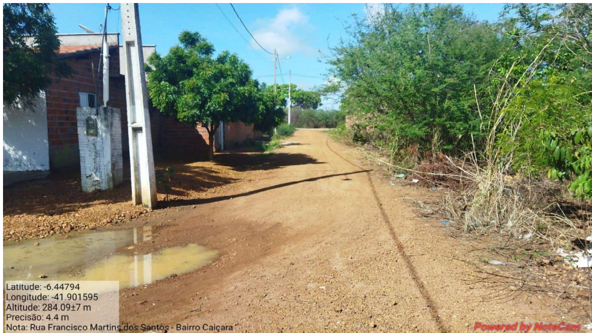
Imagem 02 – Visão Geral do final do Trecho.
