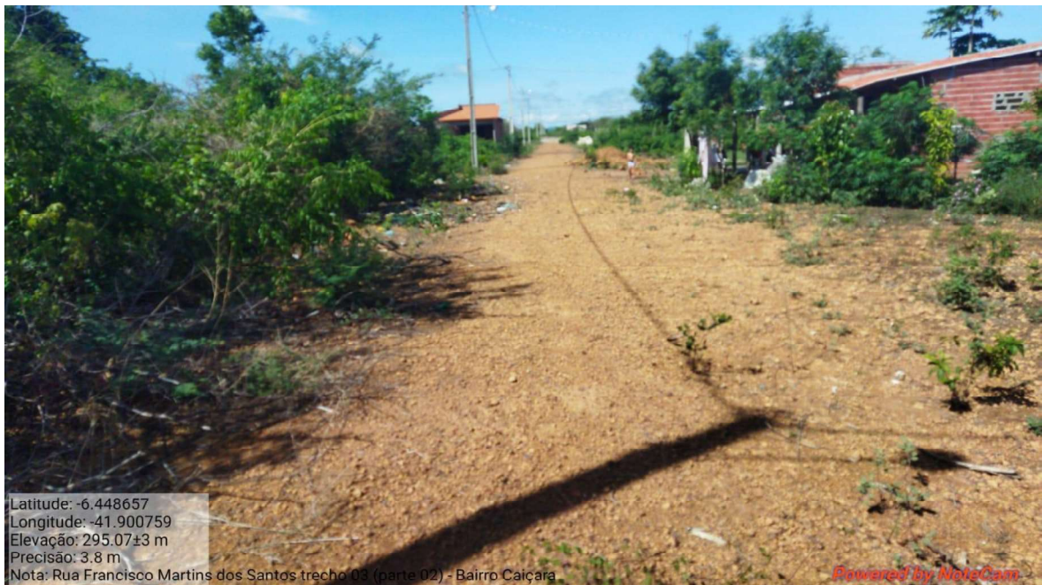
Imagem 10 – Visão geral do final do trecho.
