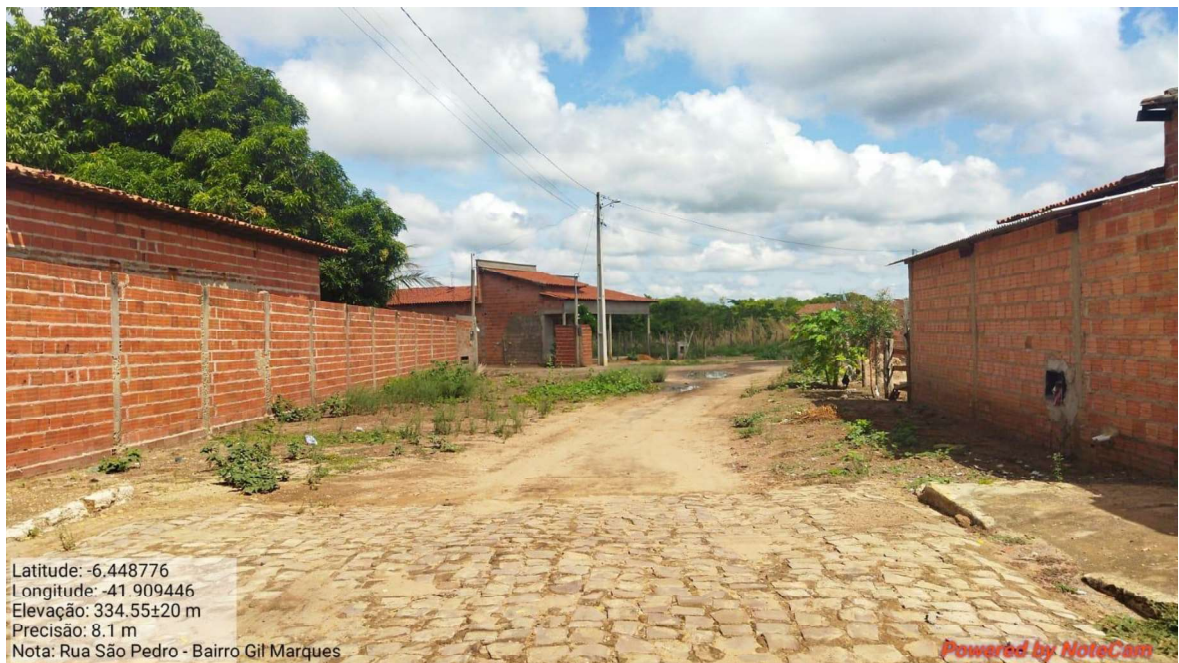
Imagem 14 – Visão geral do final do trecho
