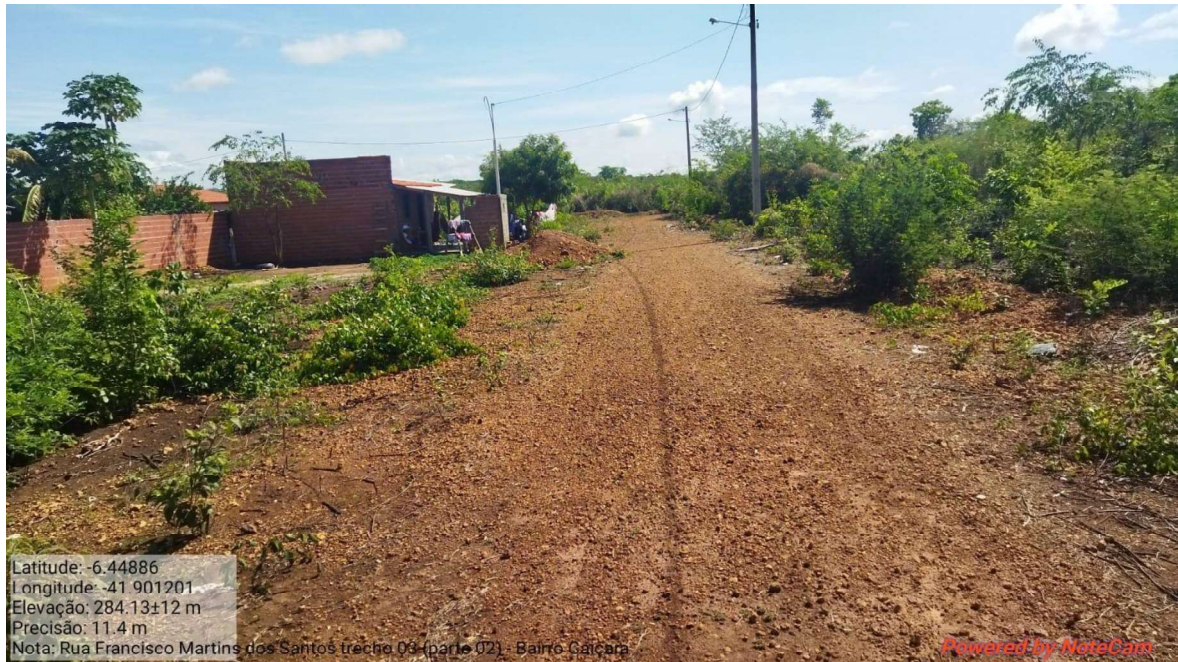
Imagem 09 – Visão geral do início do trecho.
