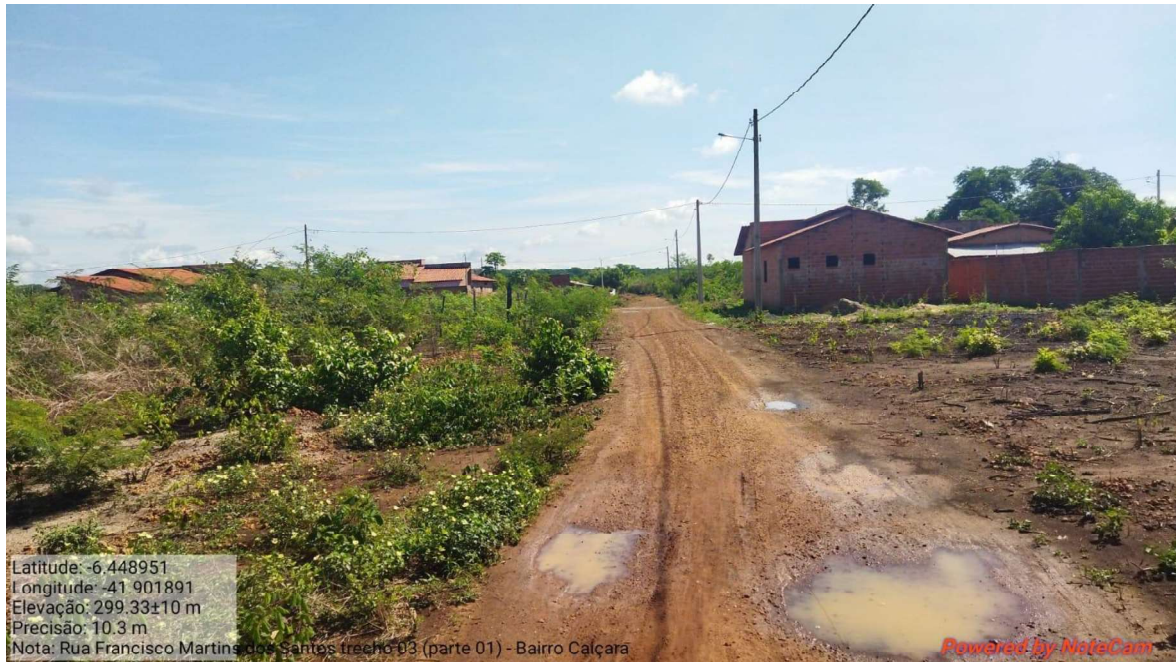
Imagem 07 – Visão geral do início do trecho.
