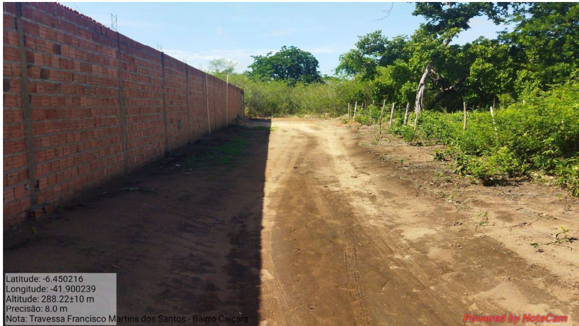
Imagem 05 – Visão geral do início do trecho.
