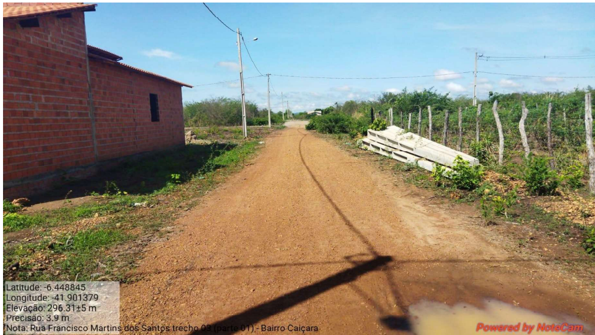
Imagem 08 – Visão geral do final do trecho.
