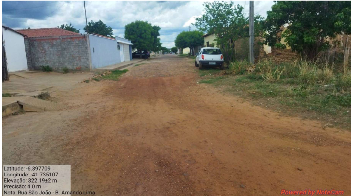
Imagem 21 – Visão geral do início do trecho.
