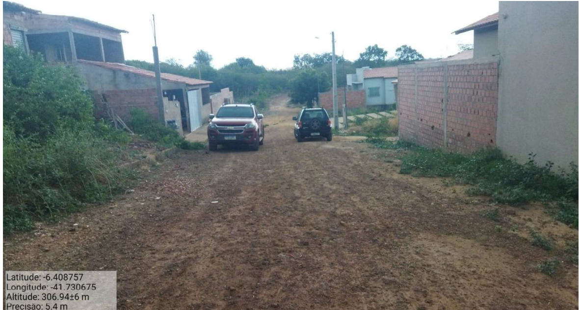
Imagem 35 – Visão geral do início do trecho.
