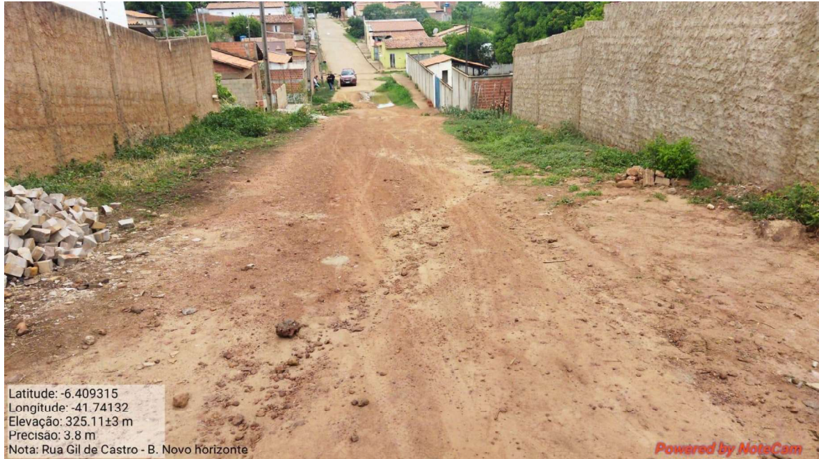
Imagem 27 – Visão geral do início do trecho.
