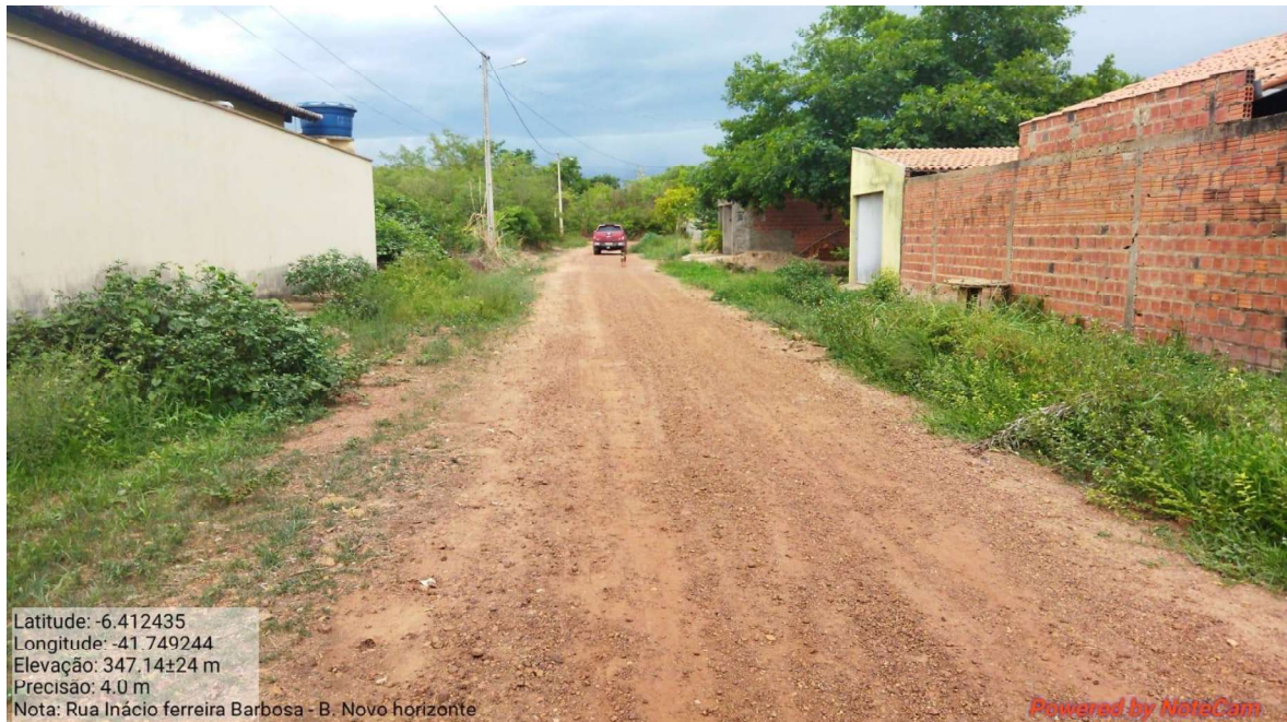
Imagem 31 – Visão geral do início do trecho.
