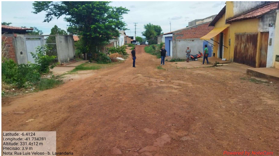
Imagem 07 – Visão geral do início do trecho.
