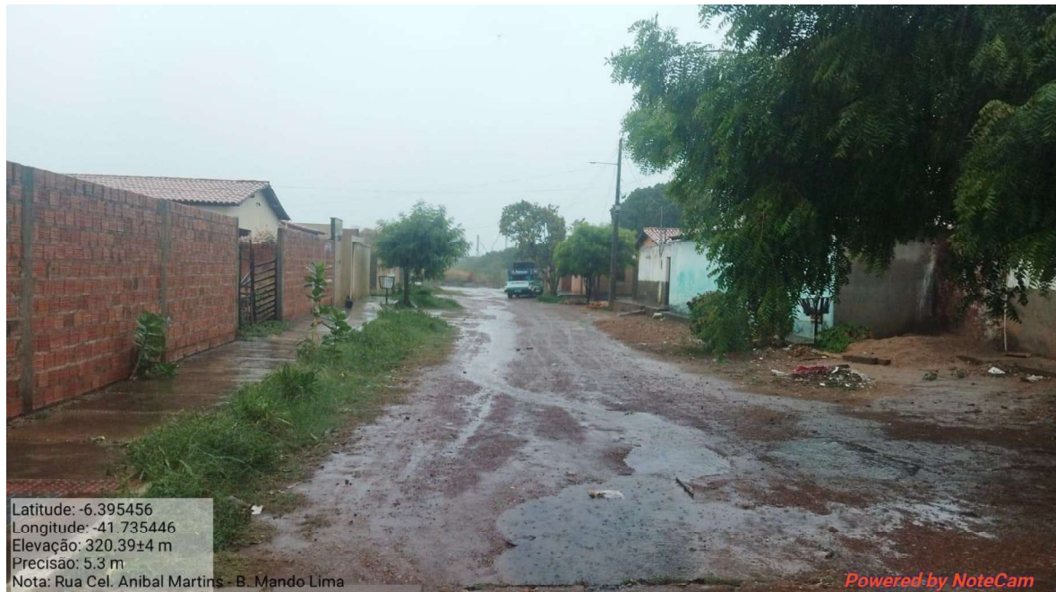
Imagem 39 – Visão geral do início do trecho.
