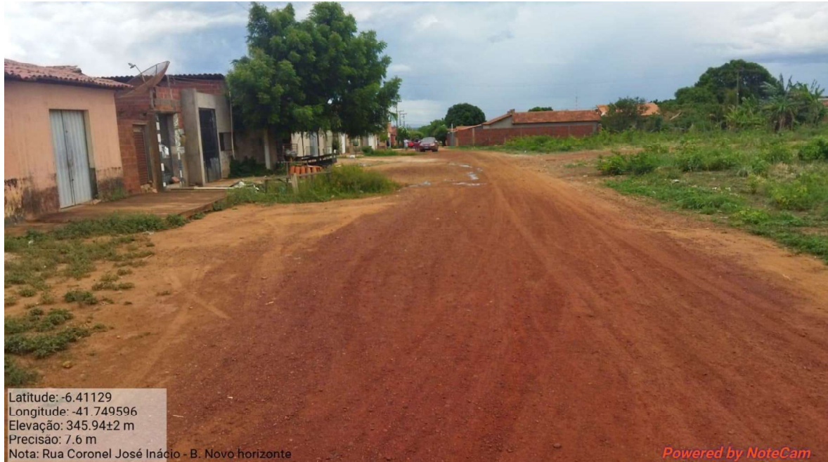
Imagem 29 – Visão geral do início do trecho.
