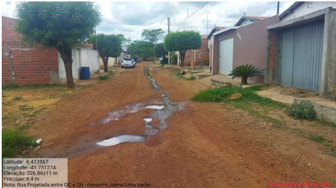
Imagem 15 – Visão geral do início do trecho.
