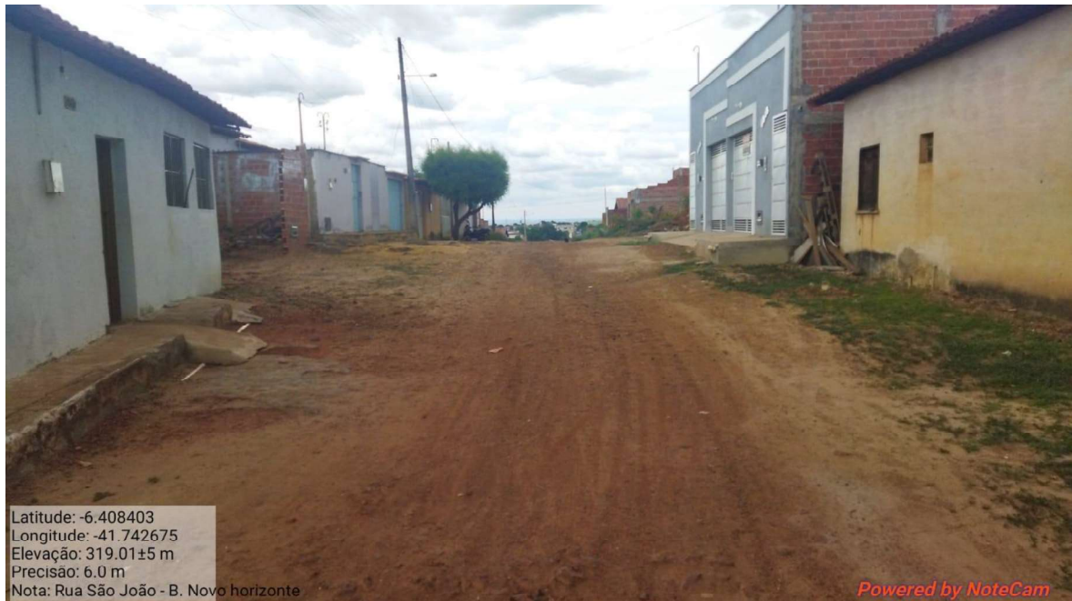
Imagem 25 – Visão geral do início do trecho.
