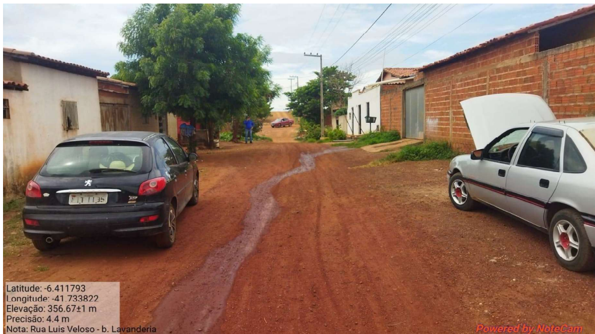
Imagem 08 – Visão geral do final do trecho
