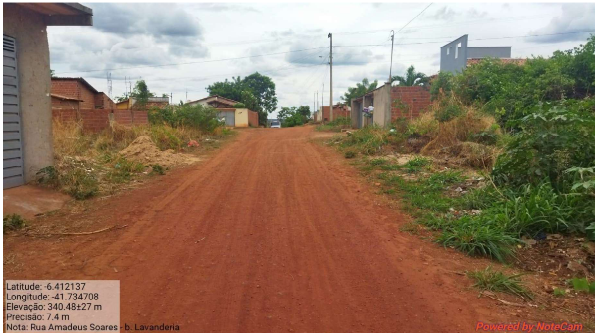
Imagem 05 – Visão geral do início do trecho.
