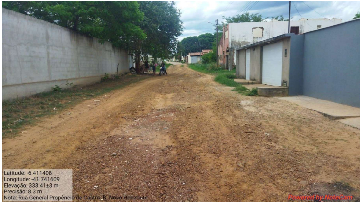
Imagem 17 – Visão geral do início do trecho.
