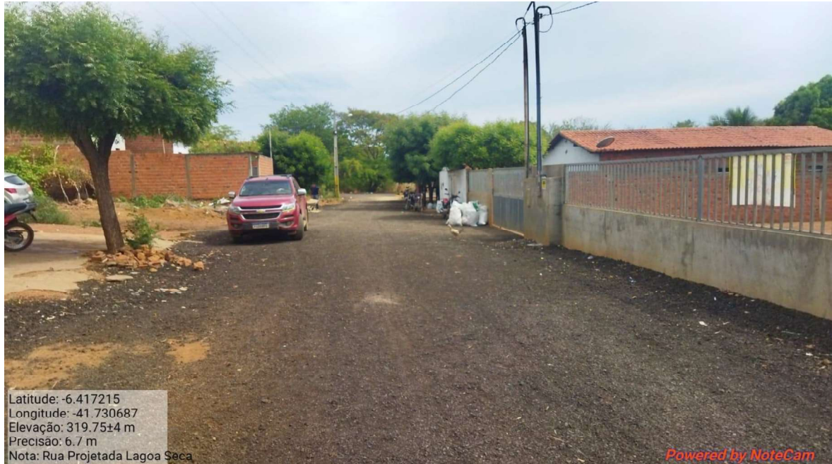
Imagem 01 – Visão geral do início do trecho.
