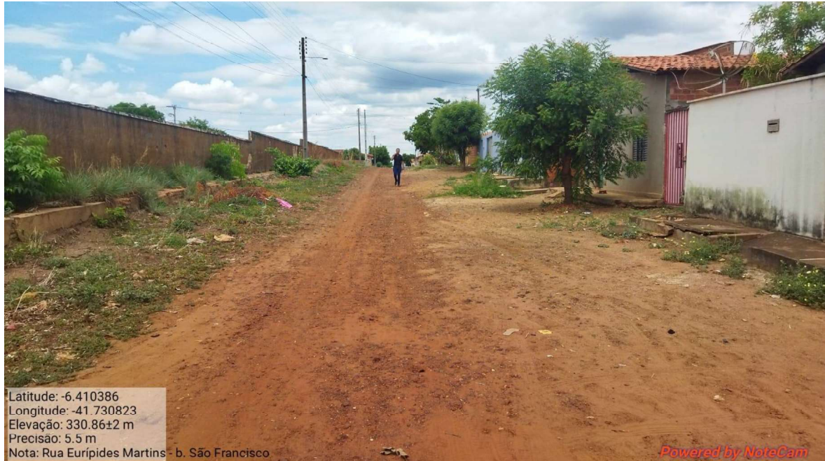
Imagem 11 – Visão geral do início do trecho.
