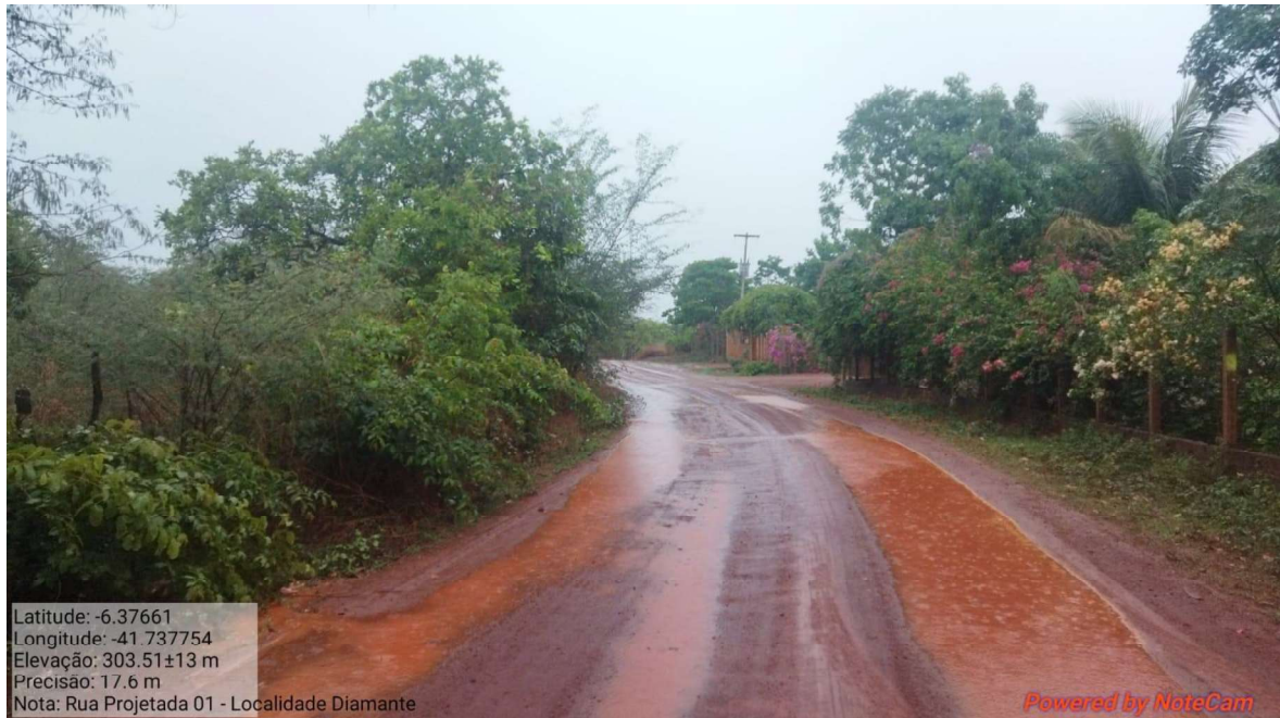
Imagem 43 – Visão geral do início do trecho.
