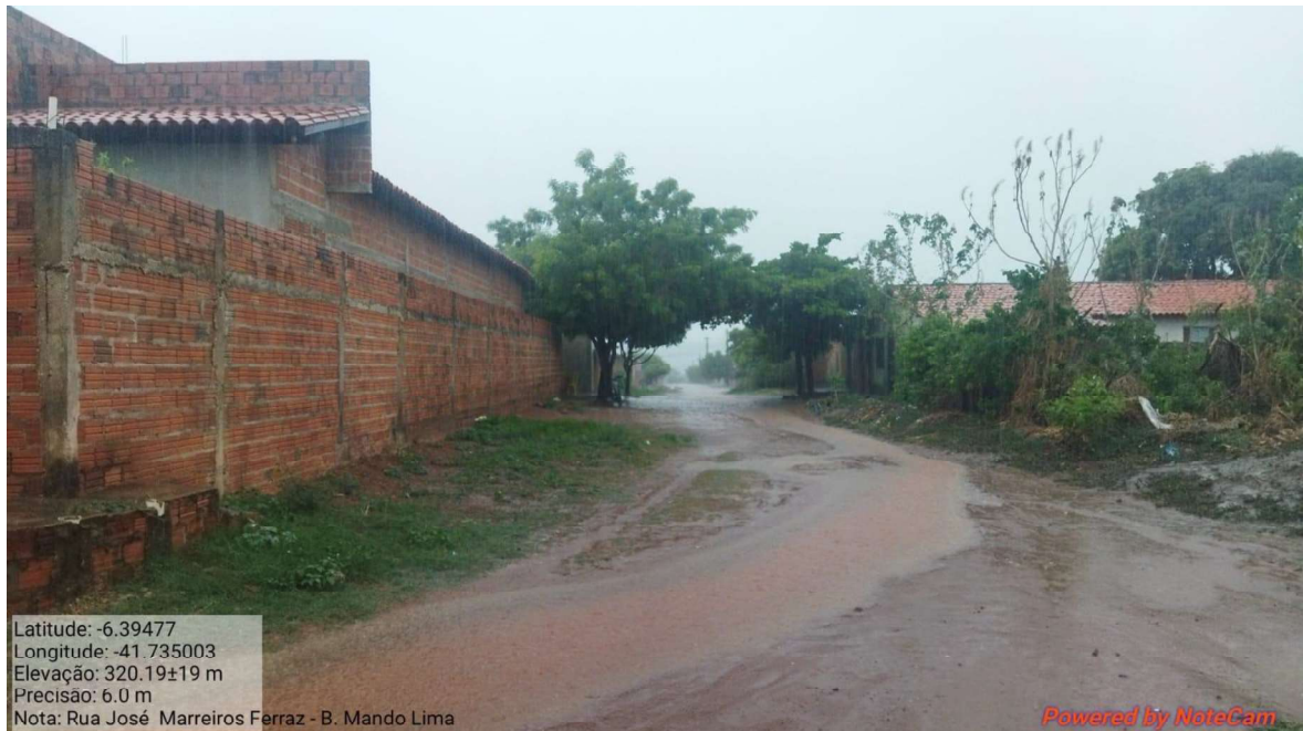
Imagem 41 – Visão geral do início do trecho.
