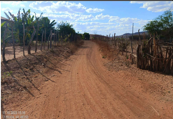
FOTO 01: TRECHO LOCALIDADE LAJINHA - INÍCIO
