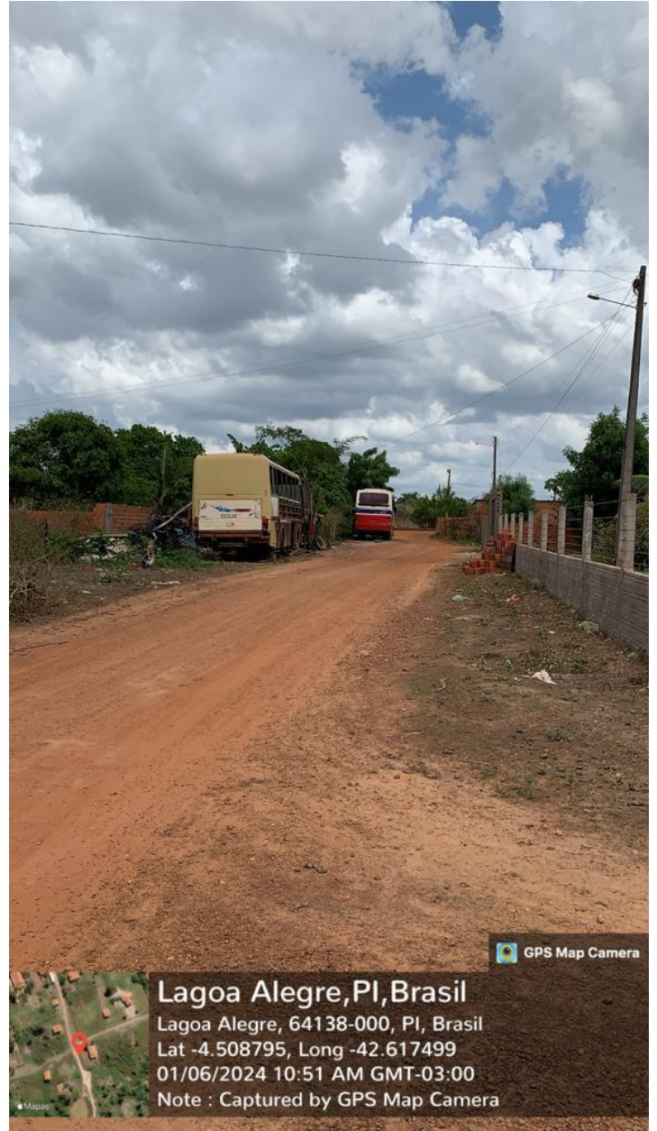
FIM RUA PROJETADA 04
