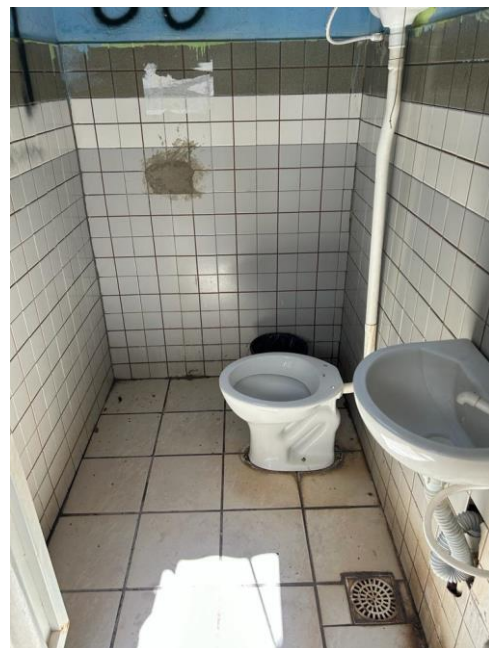
Foto 04: Banheiro Masculino; 6°58'55.64"S; 41°13'56.75"O
