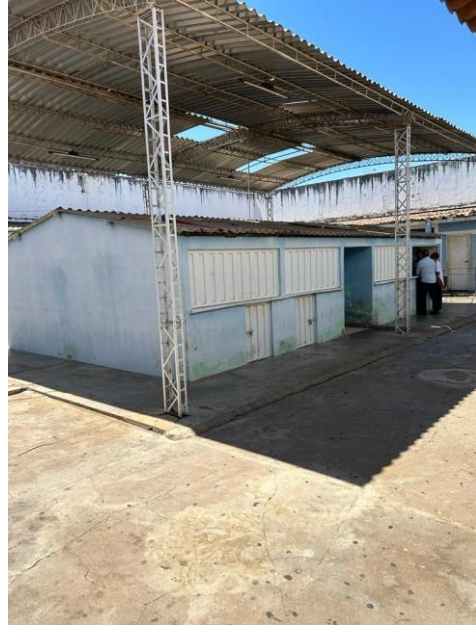
Foto 02: Área interna do mercado municipal, áreas dos boxes; 6°58'55.64"S; 41°13'56.75"O
