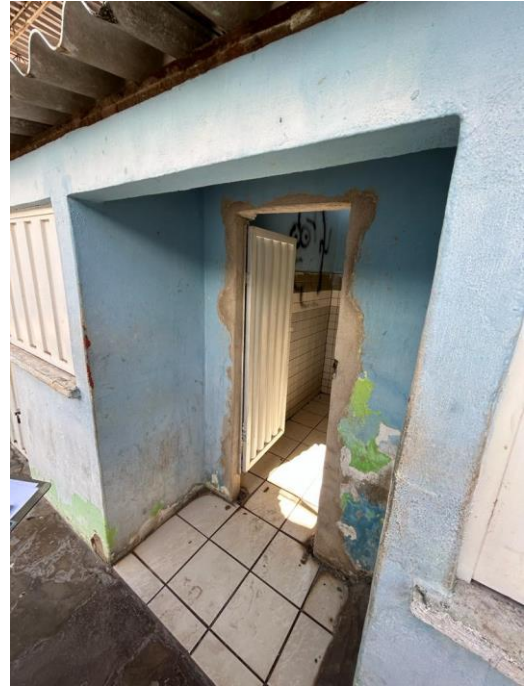
Foto 06: Entrada do banheiro; 6°58'55.64"S; 41°13'56.75"O.
