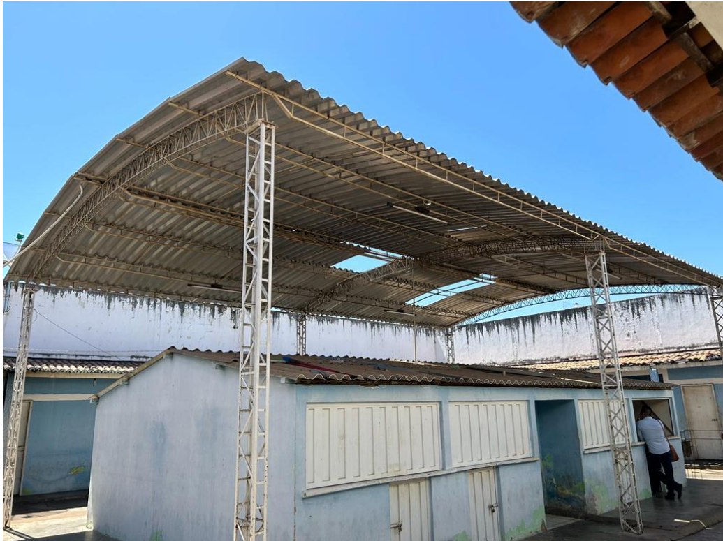
Foto 08: Área interna do mercado municipal, áreas dos boxes; 6°58'55.64"S; 41°13'56.75"O.
