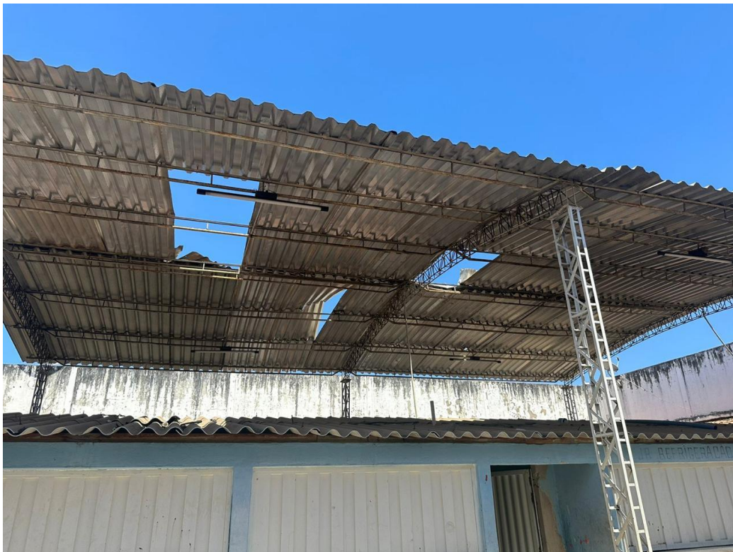
Foto 07: Cobertura Central; 6°58'55.64"S; 41°13'56.75"O.
