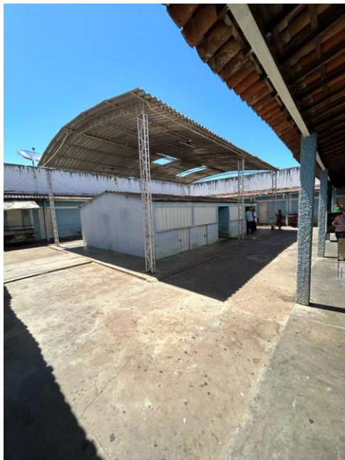
Foto 03: Área interna do mercado municipal, áreas dos boxes; 6°58'55.64"S; 41°13'56.75"O
