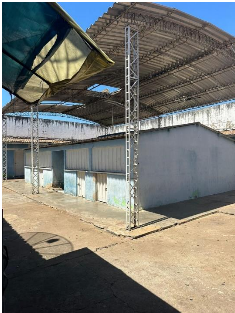
Foto 01: Área interna do mercado municipal, áreas dos boxes; 6°58'55.64"S; 41°13'56.75"O
