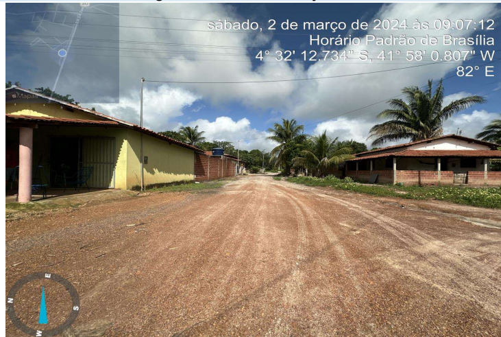
Imagem 02 - Fim da Rua Projetada 04
