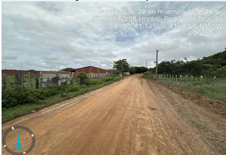
Imagem 02 - Fim da Rua Projetada 01
