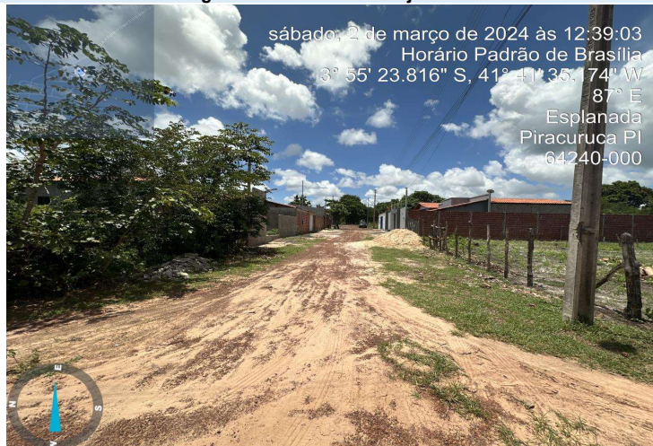
Imagem 02 - Fim da Rua Projetada 133
